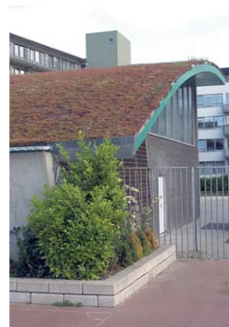
Het 'groene' dak van de 8e Montessori School op de hoek C. van Eesterenlaan - Borneokade
