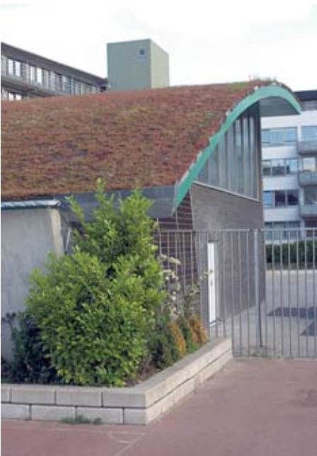
Het 'groene' dak van de 8e Montessori School op de hoek C. van Eesterenlaan - Borneokade
